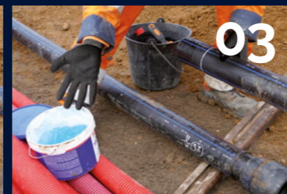
03 Lubrifier le joint d'étanchéité
