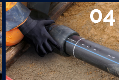
04 Emboîter le tube jusqu'à l'indicateur d'insertion
