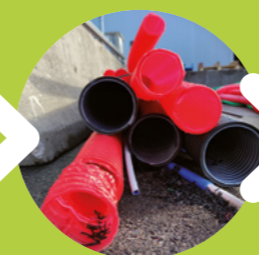
CHUTES DE CHANTIER
